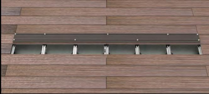
Colocación de los clips en las tablas alineados con el rastrel en disposición zigzag excepto en las dos testas.
